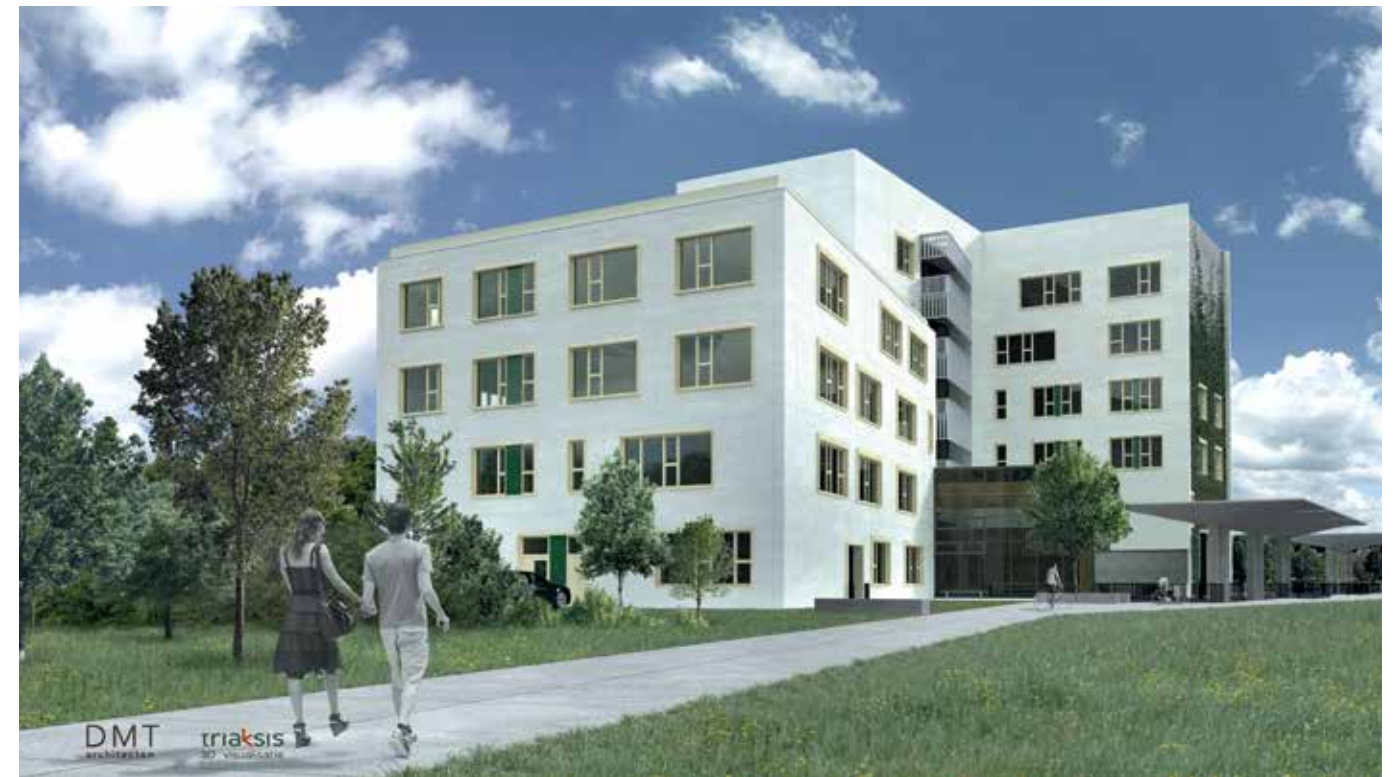
Gebouw Z, de nieuwe thuisbasis van de faculteit Ingenieurswetenschappen, is een voorbeeld van energie-efficiëntie en sturing. (Beeld: DMT - triaxis)
